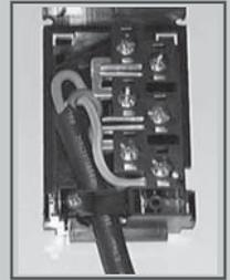
Attention : un mauvais serrage peut entraîner des risques d'échauffement dangereux au niveau du câble d'alimentation.
